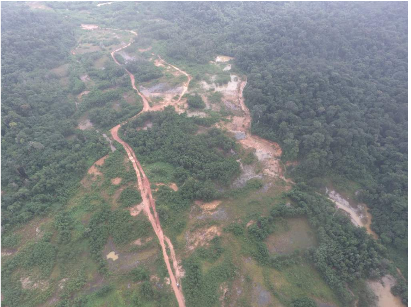
Figure 71 : Secteur Sud concession (hors renouvellement) – Prise de vue du 05/02/2021
