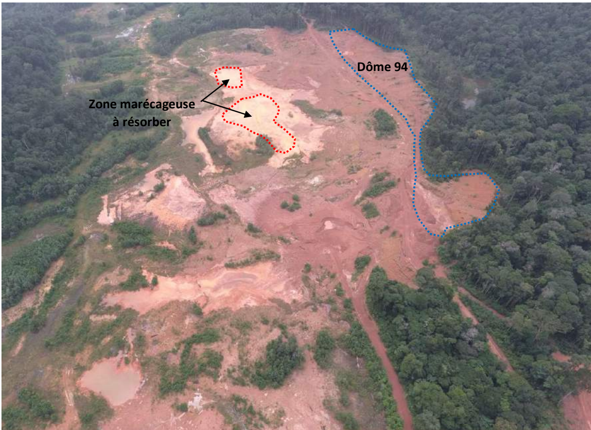
Figure 68 : Zone CB 17 - Sud du camp DOYLE – Secteur Sud – Prise de vue du 05/02/2021
