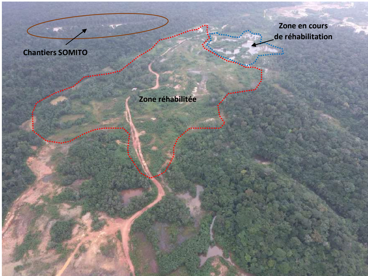
Figure 66 : Secteur Z 21 / Z 22 – Vue générale – Prise de vue du 05/02/2021
