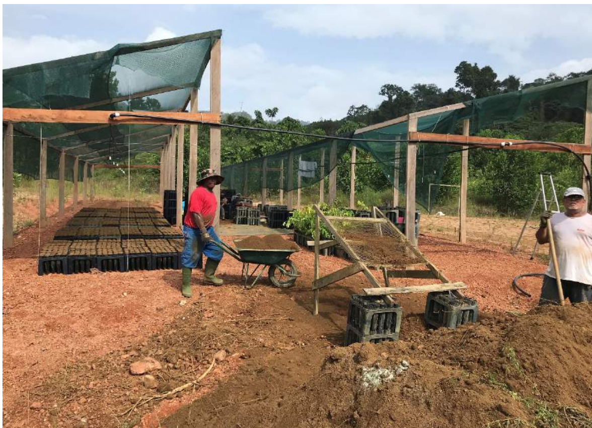
Figure 49 : Mise en place de la pépinière de CENTRAL BIEF fin 2019
