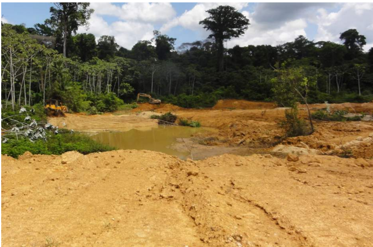
Figure 35 : Comblement des bassins, réglage des terres de découverte
