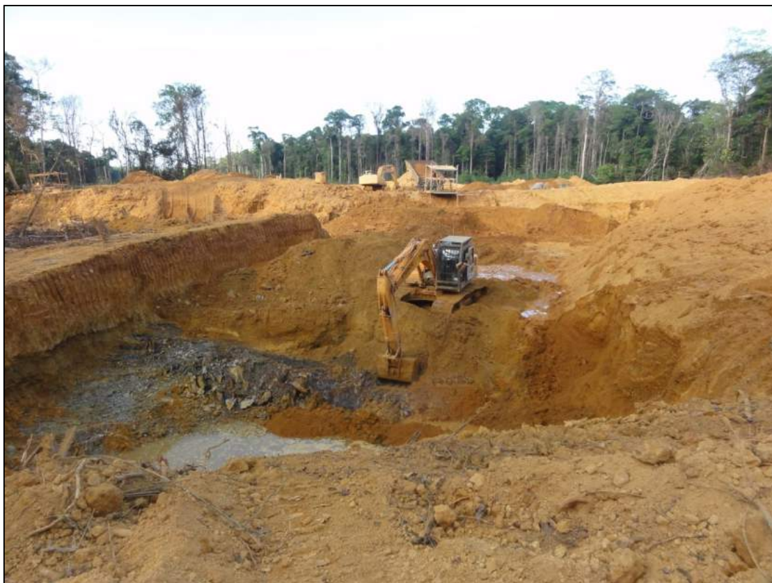
Figure 20 : Décapage et réservation des argiles stériles
